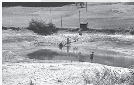
Trockenlegung des Ringwilerweiher für Unterhaltsarbeiten; u.a. an den beiden Schiebern für den Grundablass und die Druckleitung (1956).
