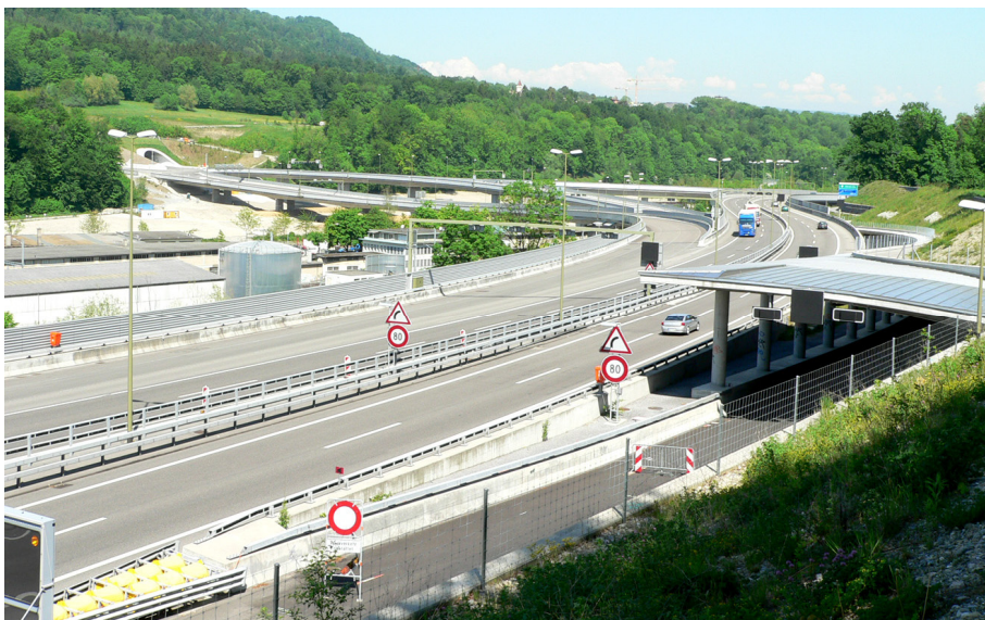
Teilansicht des Verkehrsdreiecks ZH-Süd mit Bestückung einer Signalbrücke vor dem Uetlibergtunnel
