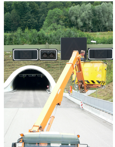
Teilansicht des Verkehrsdreiecks ZH-Süd mit Bestückung einer Signalbrücke vor dem Uetlibergtunnel
