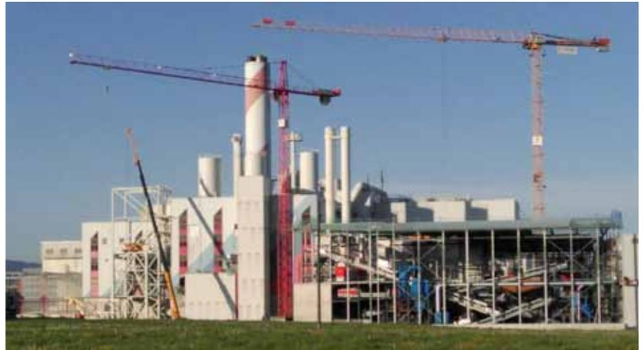
Recyclinganlage im Bau; links die Aufbereitung, rechts Triage und Containerbahnhof
