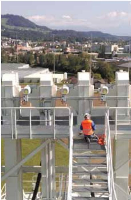
Blitzschutzinstallation für elektr. Anlagen der Aufbereitung auf 45m Höhe
